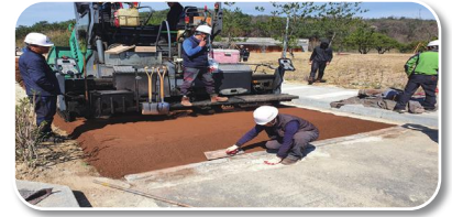
조인트 쇠흙손 작업
