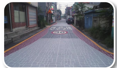
⑥ 시공 완료
