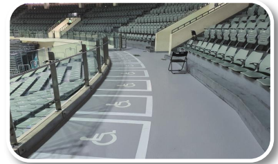
④ 시공 완료
