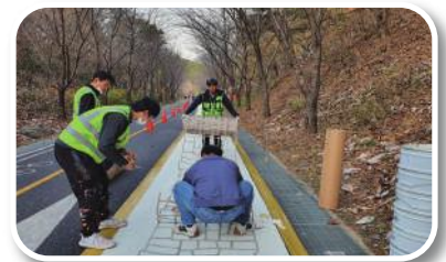
④ 문양지 설치
